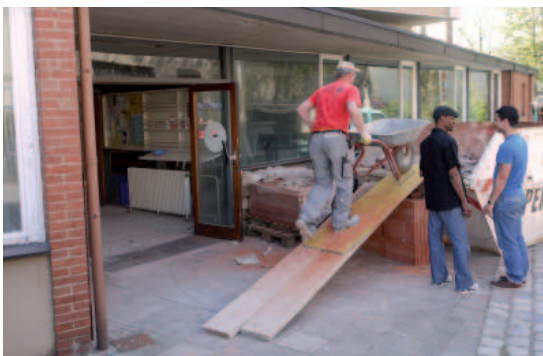
Derzeit noch Baustelle, aber bald im neuen Kleid!
