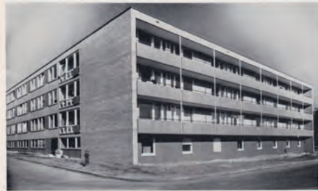
Gesamtansicht von Süden
