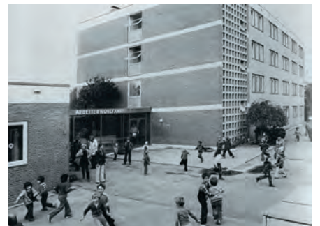
Kindergarten Weihergartenstraße. Bild: AWO Nürnberg.
